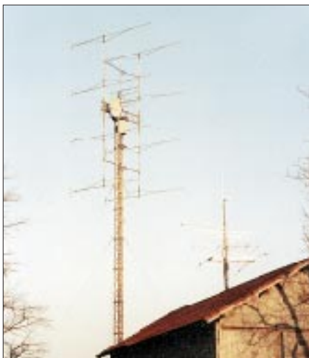
Imposante Antennenanlage von DK00G (JN68GI) in herbstlicher Sonne. Foto via DF7RG
